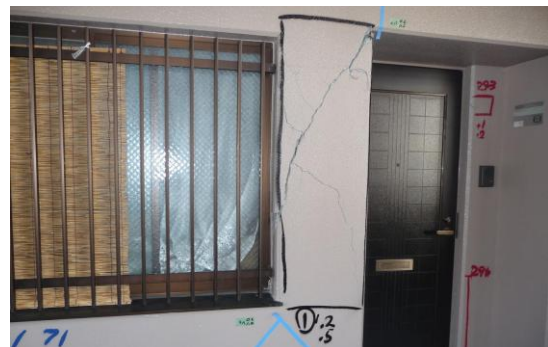
補修箇所のマーキング
