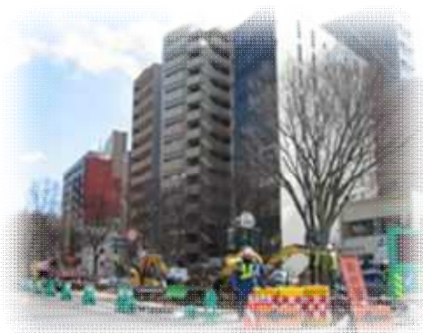
青葉通りの撤去作業
